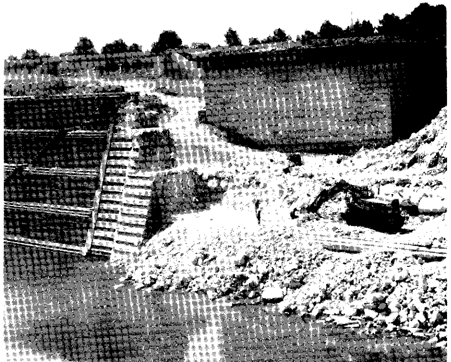
Panoramica del muro in fase avanzata dei lavori di demolizione.
